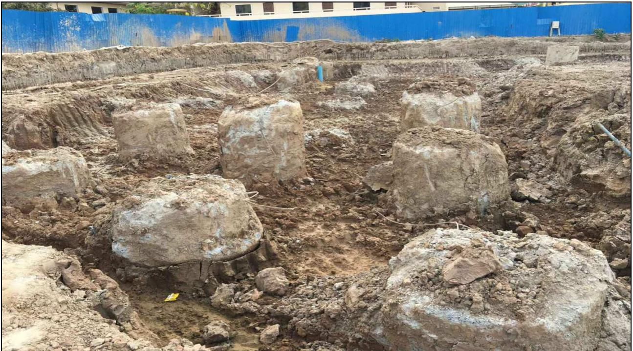
※ 進行 45 米深基樁施工工程，直接打到地下岩盤 2 米內。
