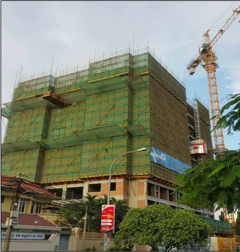
2016/02 13 樓工程已完成。
