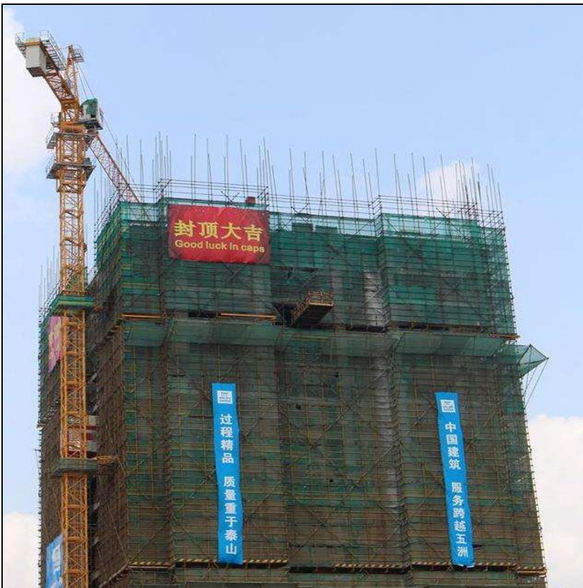
2016/05 22 樓封頂工程已完成。
